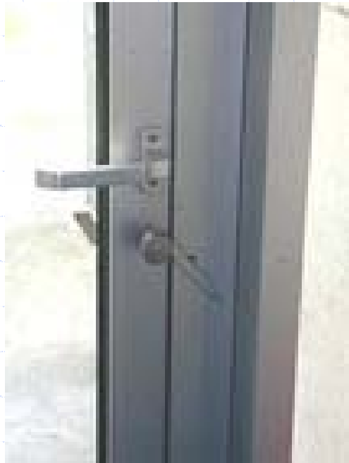
Plomben an Türen
